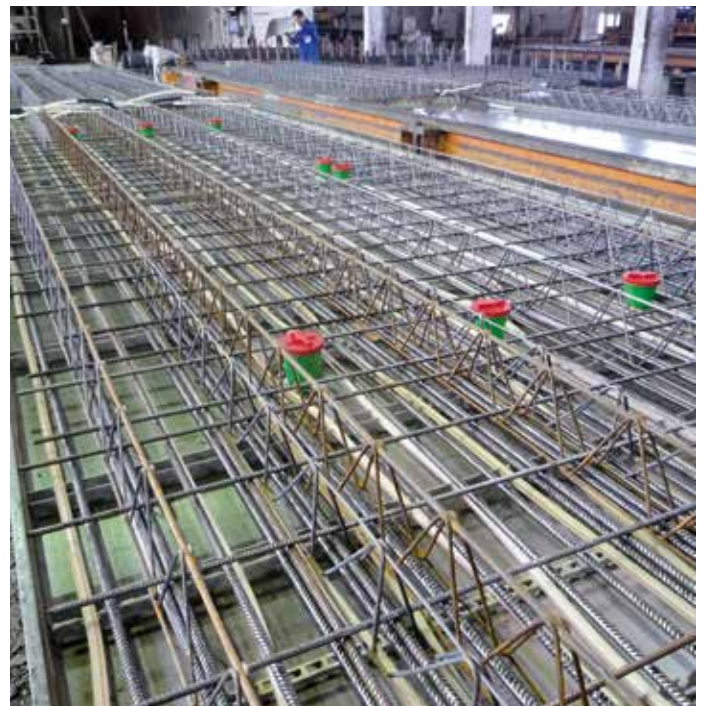
Der hohe Vorfertigungsgrad vereinfacht die Montage auf der Baustelle erheblich.
