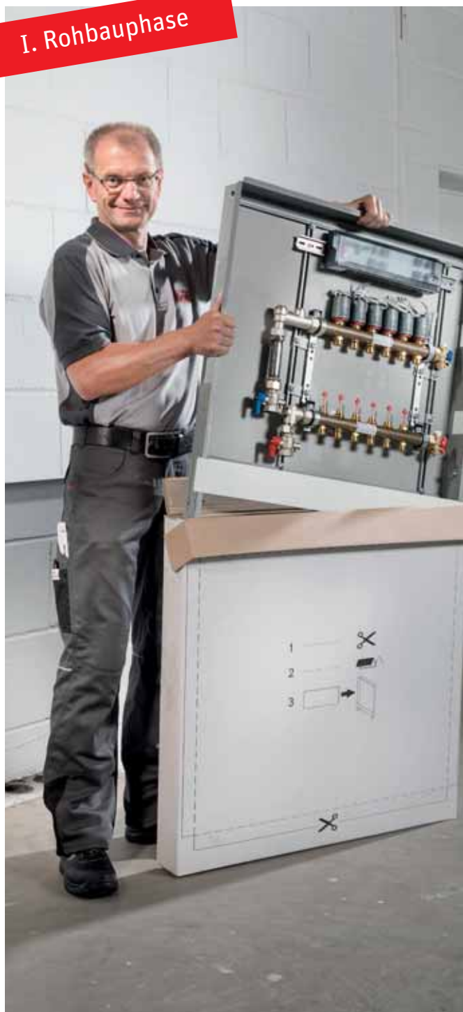
1. Einsetzen des werkseitig vormontierten Verteilerschranks.
