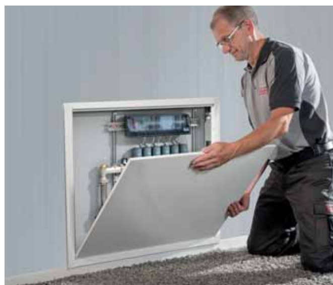
6. Einfaches Einsetzen von Rahmen und Tür.
