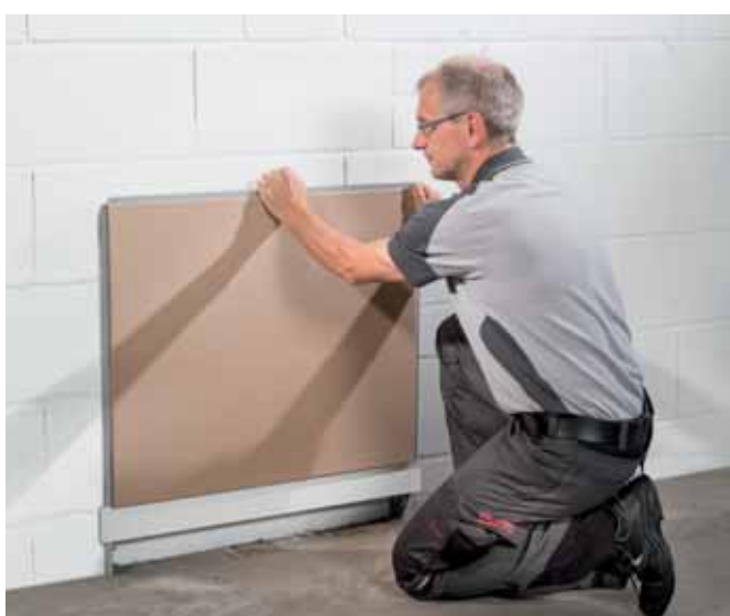
4. Die Schutz-Schablone komplett aufsetzen.
