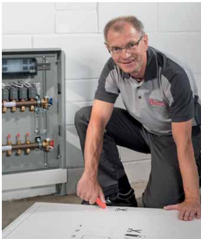
2. Ausschneiden der Schutz-Schablone während der Bauphase.
