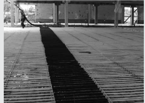
Roth Systemheizrohr im Schutzrohr – Bereich für Bewegungsfuge
