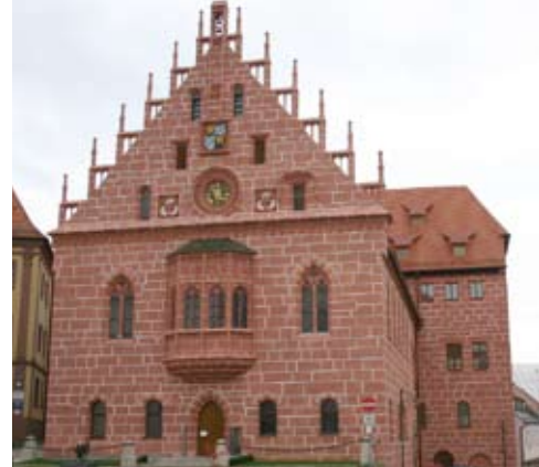
Roth Fußbodenheizung, Rathaus Rosenberg, Sulzbach-Rosenberg, Deutschland
