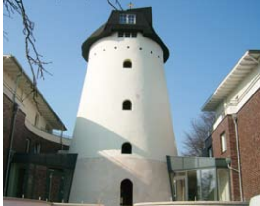
Roth ClimaComfort-System, Wohnanlage Luggesmühle, Bottrop, Deutschland
