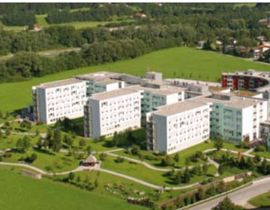
Roth Fußbodenheizung, Bezirkskrankenhaus, Kufstein-Endbach, Österreich
