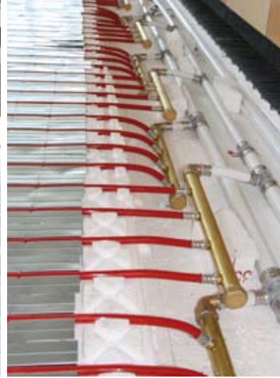
Die Anbindung der Heizkreise der Roth KlimaComfort® TBS Flächenheizung in der Hinterlandhalle Dautphetal erfolgt über ein Tichelmann-Verteilungsnetz.
