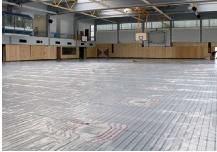
Die Anbindung der Heizkreise der Roth KlimaComfort® TBS Flächenheizung in der Hinterlandhalle Dautphetal erfolgt über ein Tichelmann-Verteilungsnetz.
